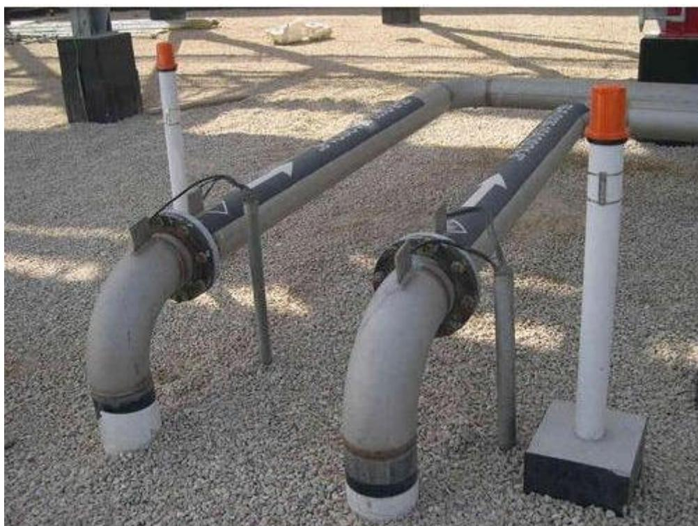
Slika 21 Vidljivi cjevovodi sa sustavom katodne zaštite. Izvor: <https://5.imimg.com/data5/ST/JO/ID/SELLER-7533635/cathodic-protection-system-for-pipelines-500x500.jpg>
