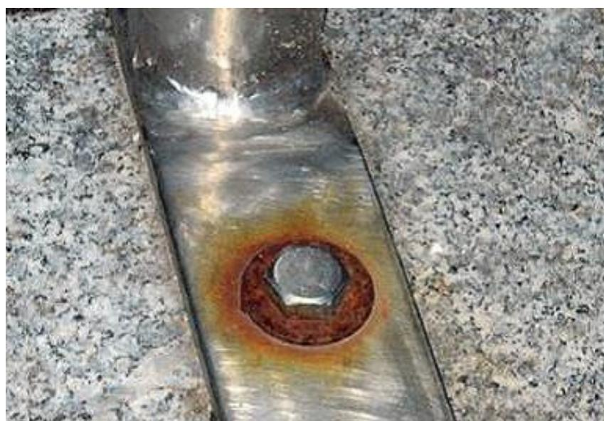
Slika 3 Česti primjer galvanske korozije koji se susreće u svakodnevnom životu. Izvor:
