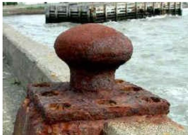
Slika 6 Primjer opće, jednolike korozije po cijelokupnoj površini. Izvor:
