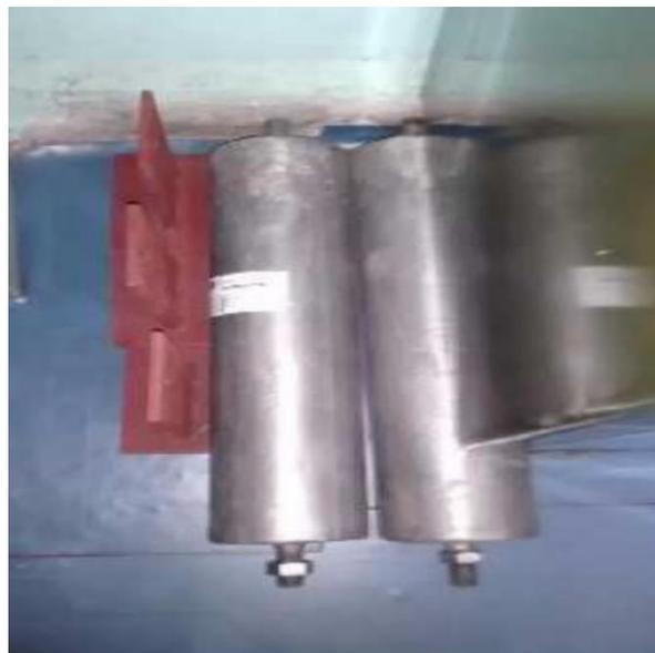
Slika 24 Primjer magnezijevih žrtvenih anoda kakve se često koriste pri katodnoj zaštiti vodenih komora kondenzatora. Izvor: Ashwini, K. (2016.) "Applications of Cathodic Protection Systems for Power Plant Components"
