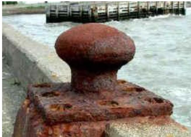
Slika 6 Primjer opće, jednolike korozije po cjelokupnoj površini. Izvor:
