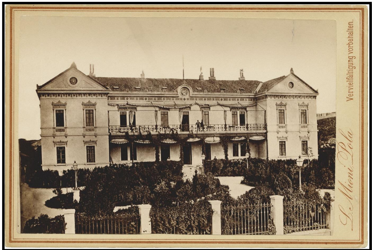
Fotografija 2: Stara zgrada Marine kasina
