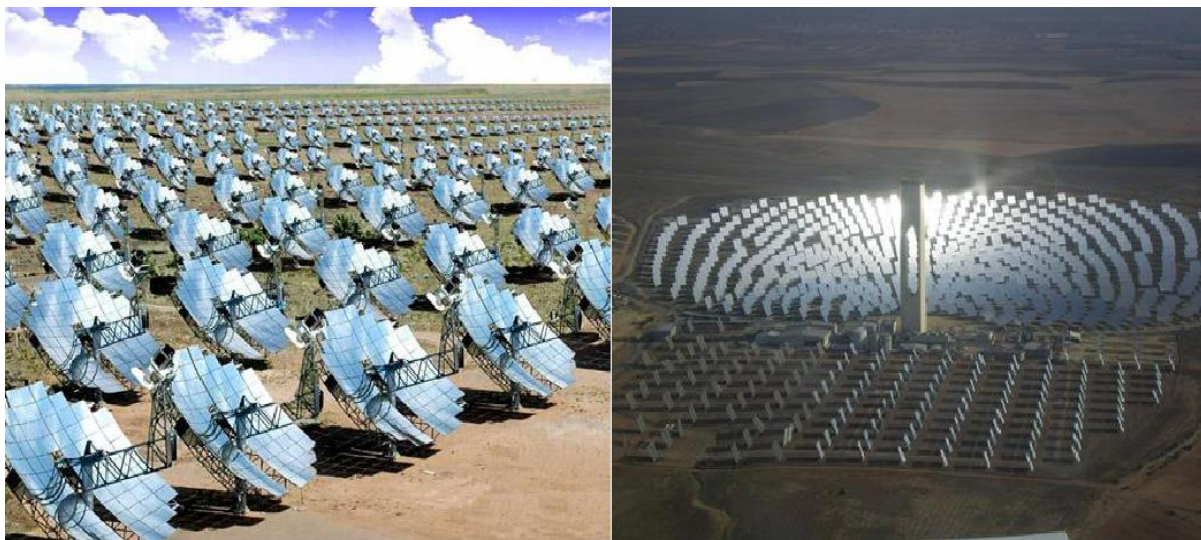
Slika 12: Solarni tanjuri (lijevo) i solarni toranj (desno)
