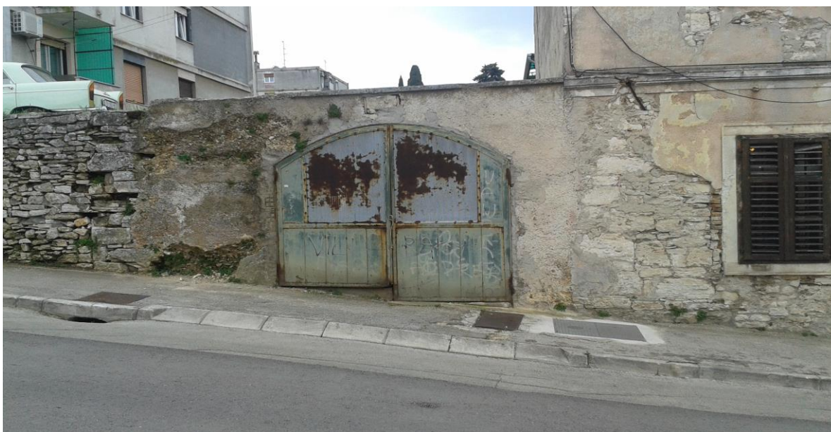
Slika 6. Sporedni izlaz/ulaz u tunel br.19 (Izvor: autor)
