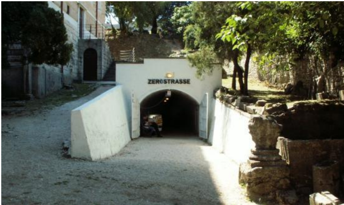
Slika 1. Ulaz u tunel Zerrostrasse (Izvor: http://www.istarski.hr/node/3785 , 12. 05. 2015.)
