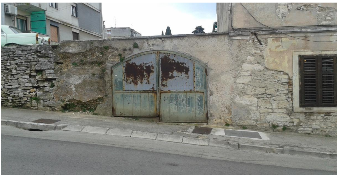
Slika 6. Sporedni izlaz/ulaz u tunel br.19 (Izvor: autor)
