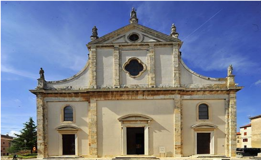
Slika 1. Crkva sv. Blaža u Vodnjanu, slika pročelja
