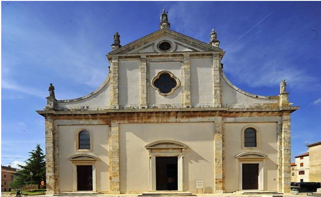
Slika 1. Crkva sv. Blaža u Vodnjanu, slika pročelja
