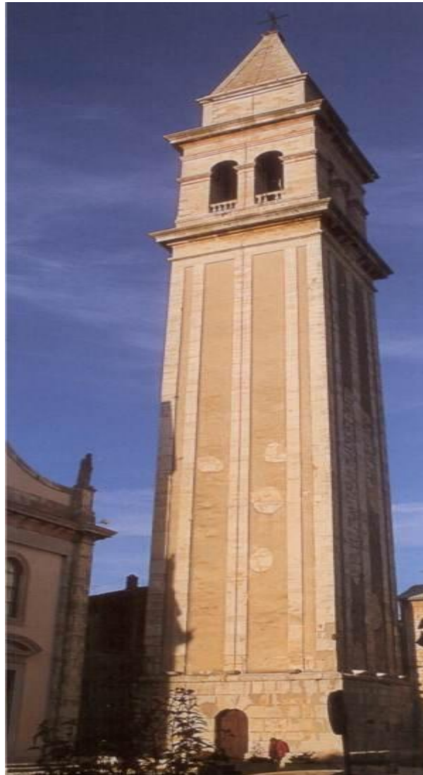
Slika 3. Slika zvonika u Vodnjanu
