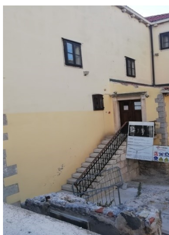
4d. Mjesto buduće dogradnje GMS
