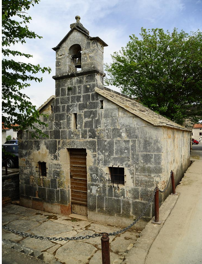
Slika 3. Crkva sv. Antona Pustinjaka, Barban
