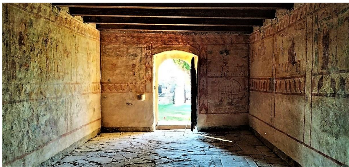
Sl. 60. Zapadni zid crkve svetog Elizeja (Fotografirao: Kristijan Žgaljardić, travanj, 2019.)
