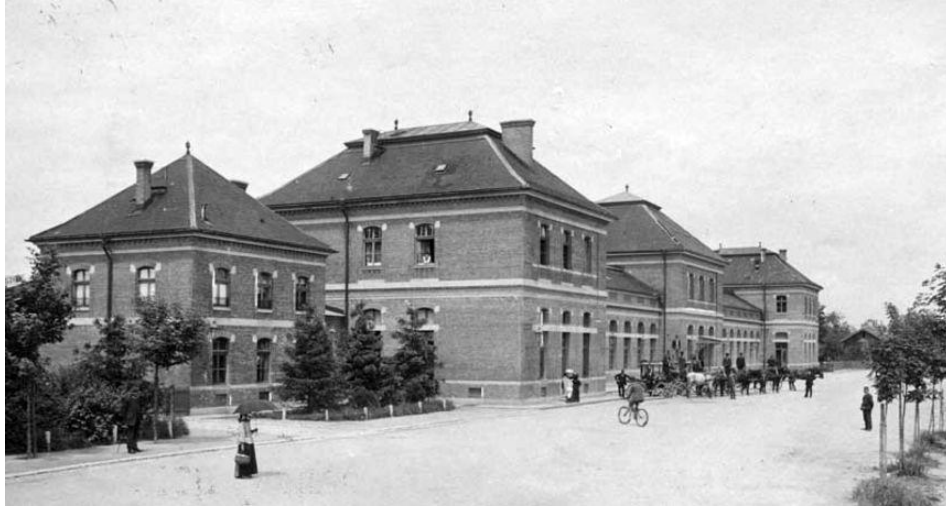
Prilog 15: Karlovački željeznički kolodvor 1865.
