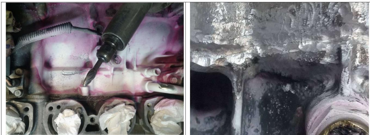
Slika 52. Nakon toga se pristupilo TIG postupku zavarivanja
