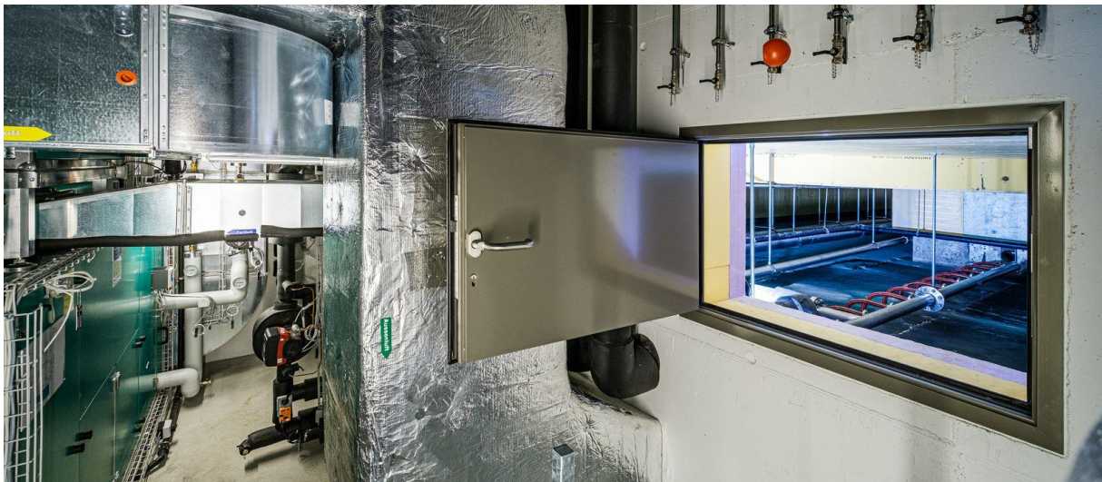
Slika 9. Ice battery za rekuperaciju topline
