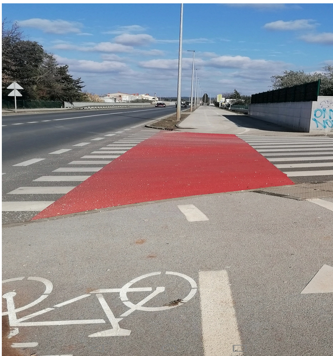
Slika 4: Kvalitetno uređena i označena biciklističke staza, sa prijelazom preko kolnika u Vodnjanskoj ulici u Puli
