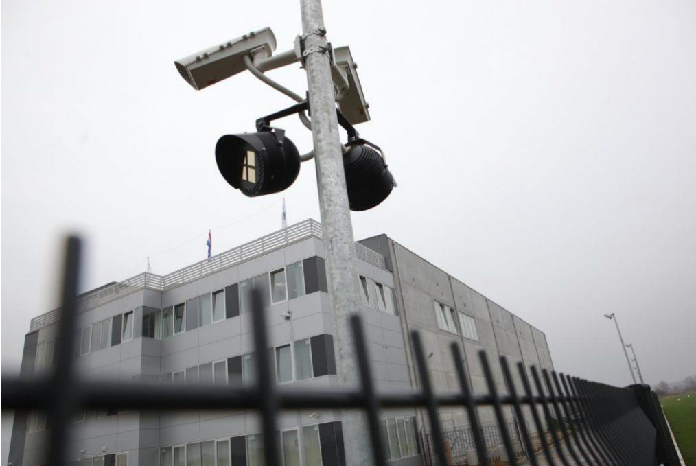
Slika 3. Protuprovala (izvor https://mydataknex.hr/o-nama/nasi-data-centri#! )
