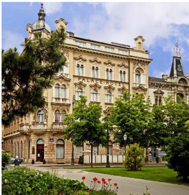
Slika 7. Palace Hotel Zagreb danas Izvor: https://sites.google.com/site/hotelpalacezagreb/galerija , posjećeno 12. srpnja 2020.
