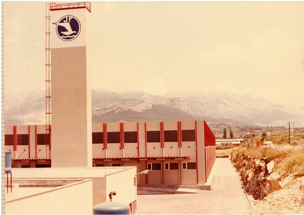
Slika 2. Zgrada nekadašnje Jugoplastike
