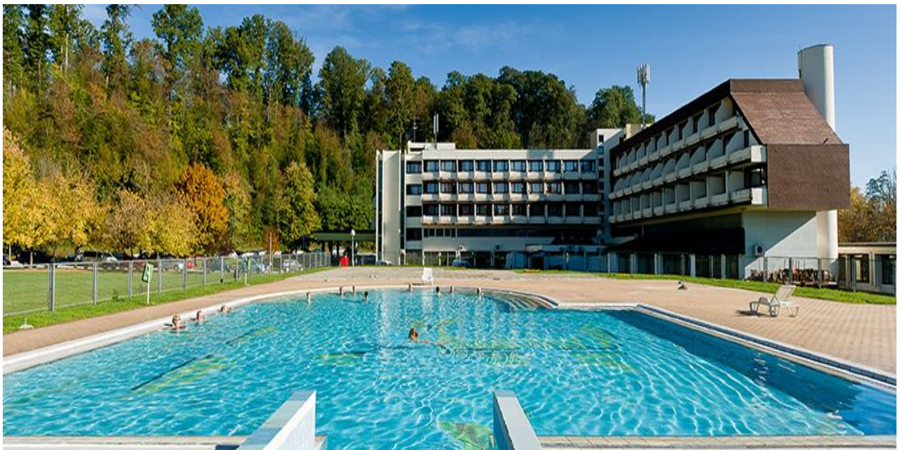
Slika 3. Termalno lječilište Topusko
