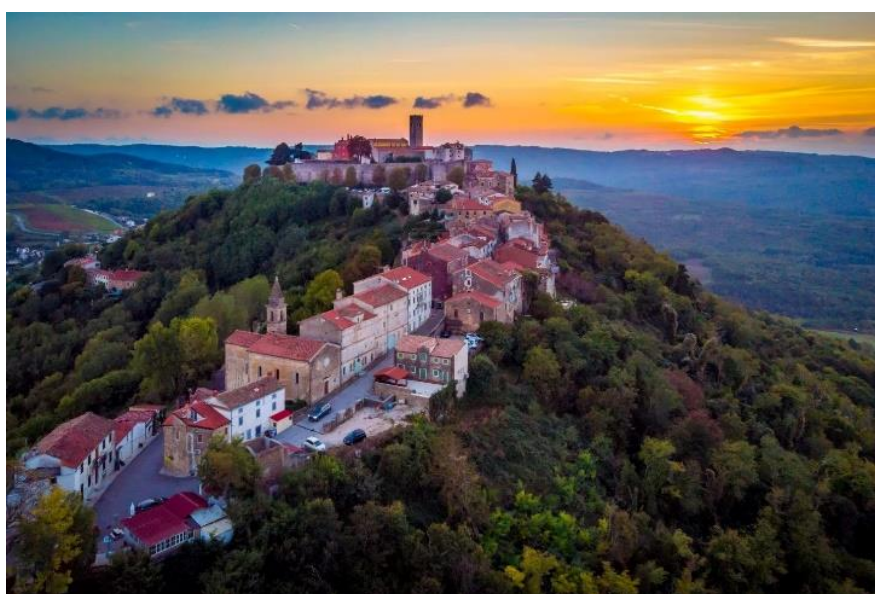
Slika 2 Pogled iznad Gradiziola (Autor: David Matković)
