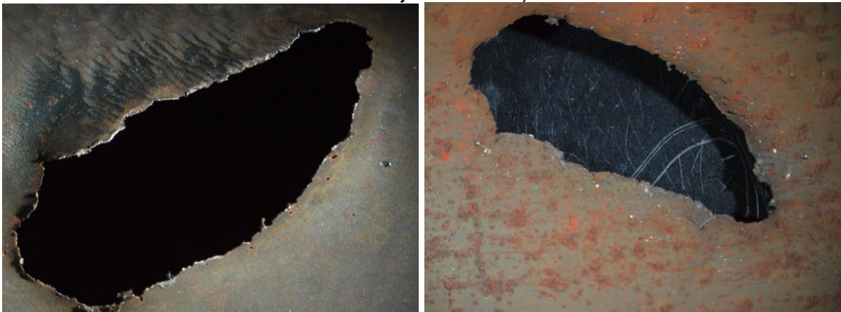
Slika 21: Područje oko pukotine na uzorku 3 (vanjska strana cijevi – lijevo, unutarnja strana cijevi – desno)
