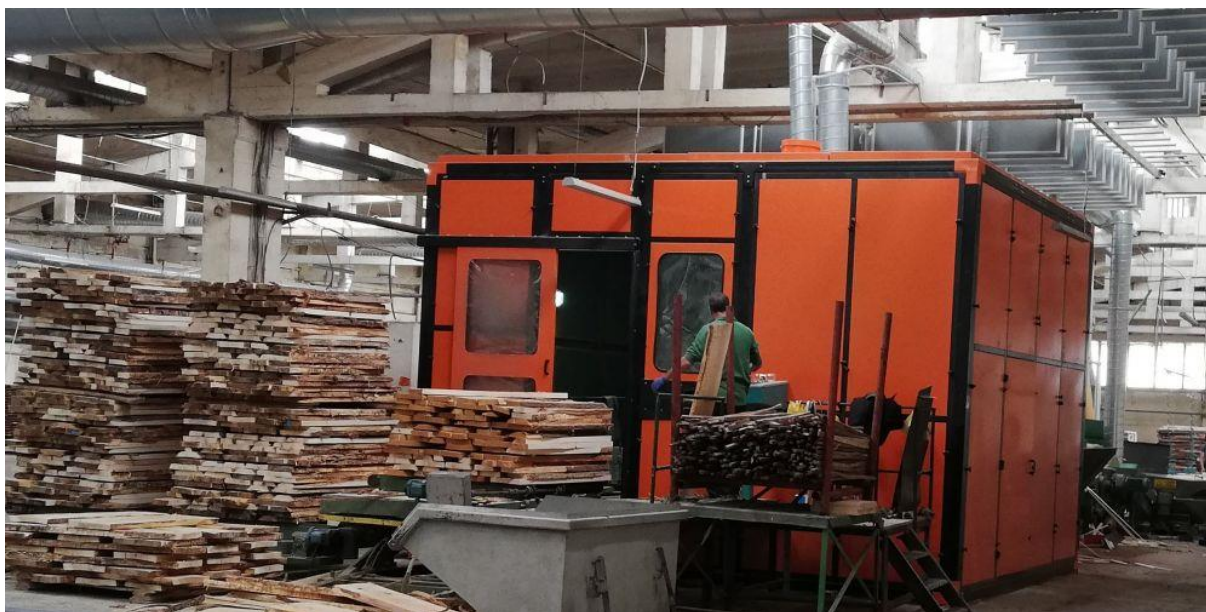
Slika 12. Vanjski izgled zvučno izolirane prostorije
