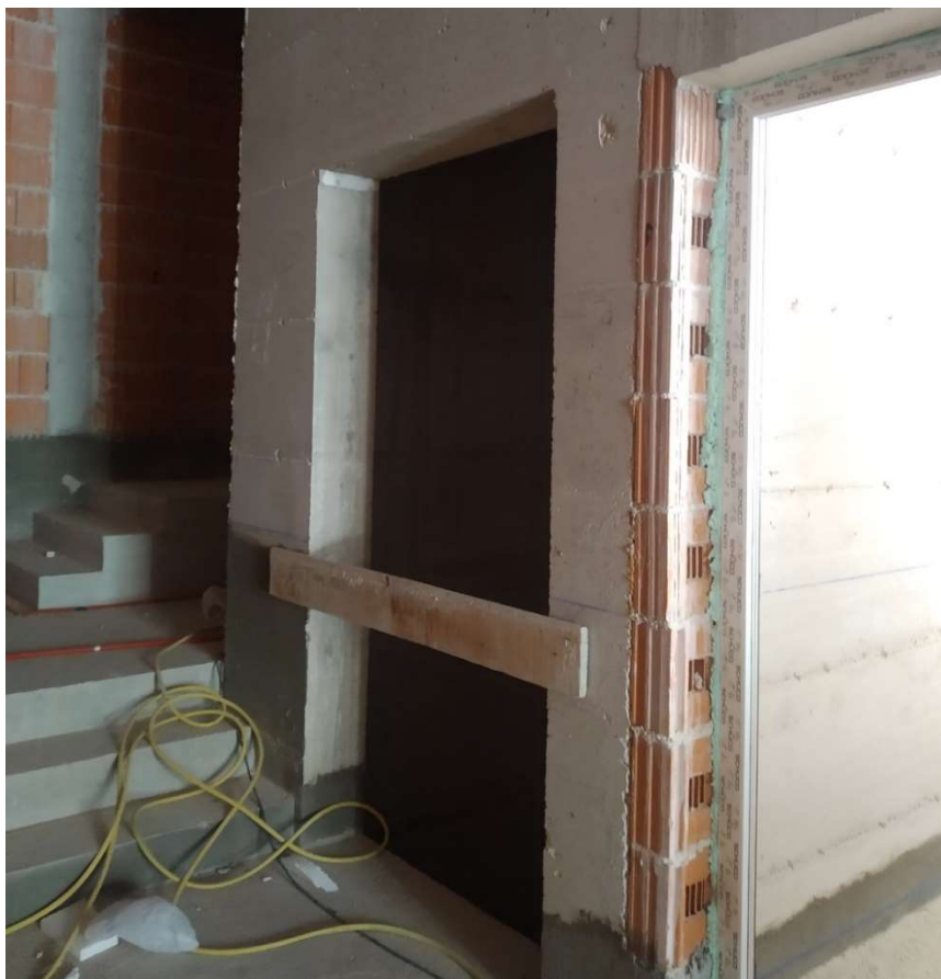
Slika 12. Okno dizala u prizemlju zgrade
