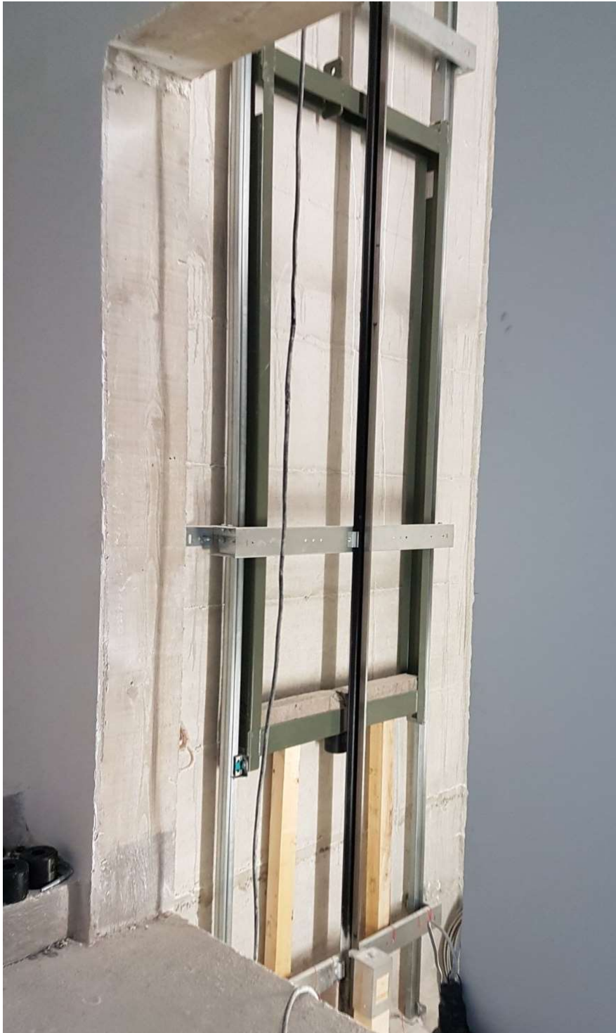
Slika 22. Okvir protuutega
