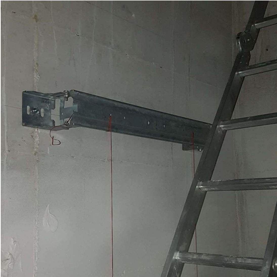
Slika 21. Omega konzola s dva viska
