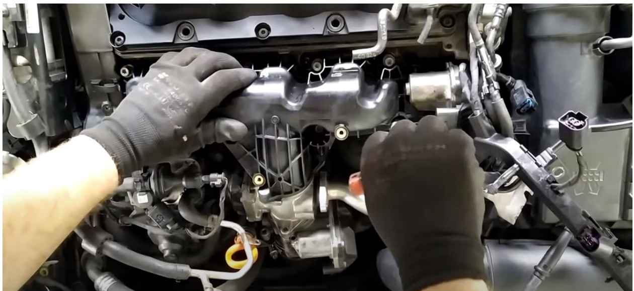
Slika 49: Proces montaže usisne grane
