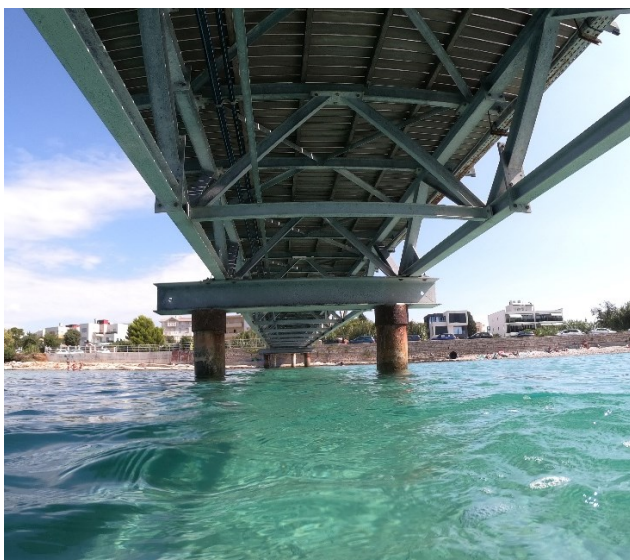
Slika 16. Most i metalni stupovi u sklopu ski-lifta izvan vode (izvor: osobna arhiva).
