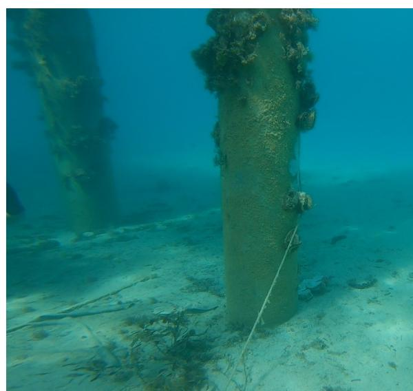
Slika 17. Metalni stupovi unutar vode s obraštajem
