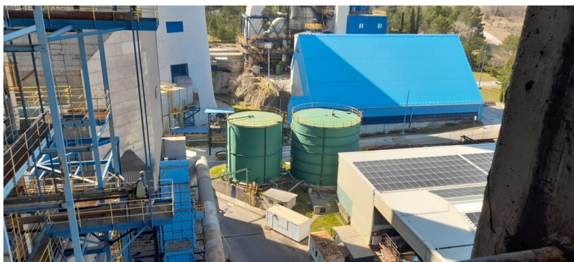
Slika 32. Spremnici sirove vode pred elektranom [autor]
