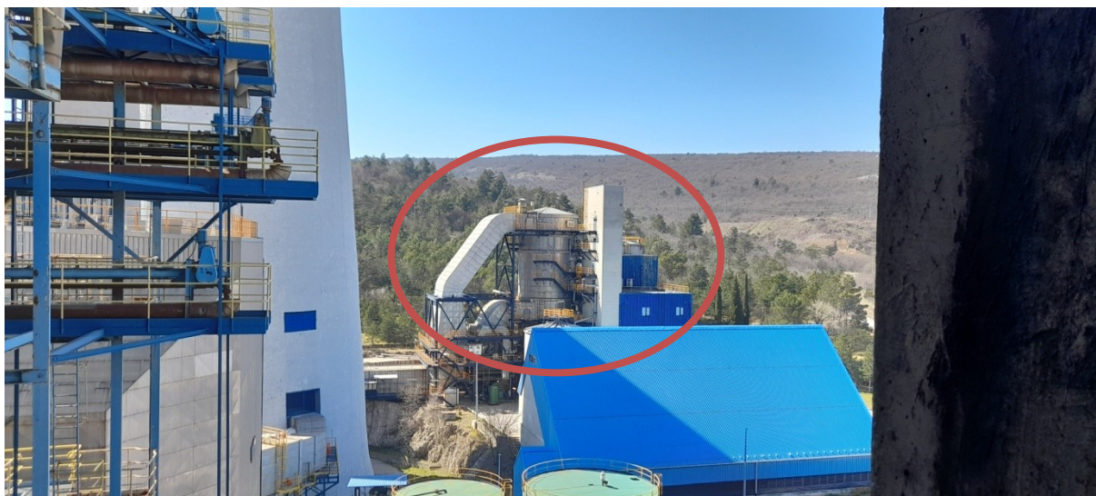
Slika 50. Postrojenje za obradu sumporovog dioksida [autor]
