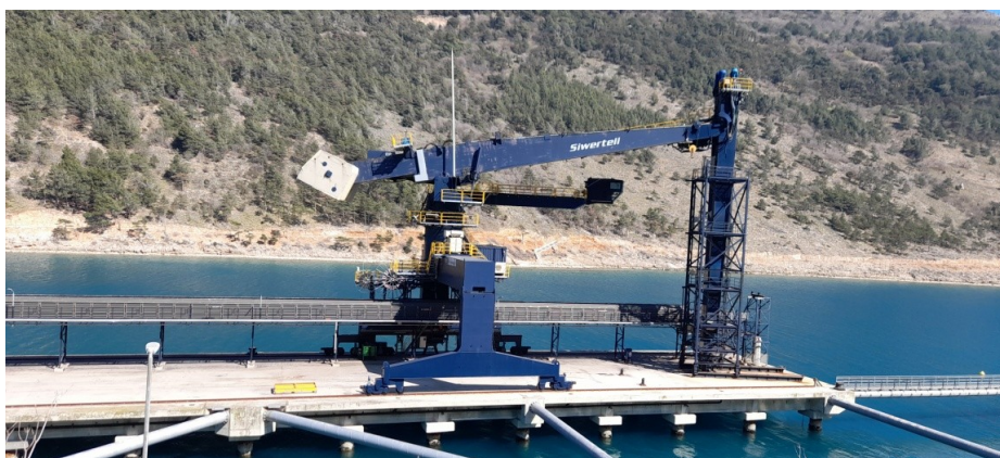
Slika 29. Zatvoreni pužni transporter ugljena na tračnicama u pristaništu [autor]
