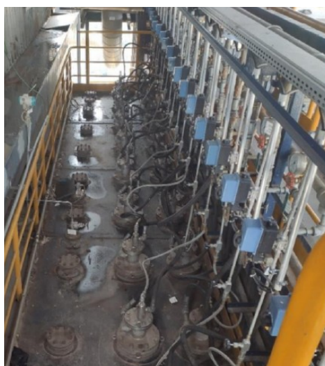
Slika 51. Tlačni sustav dušične vode [11]
