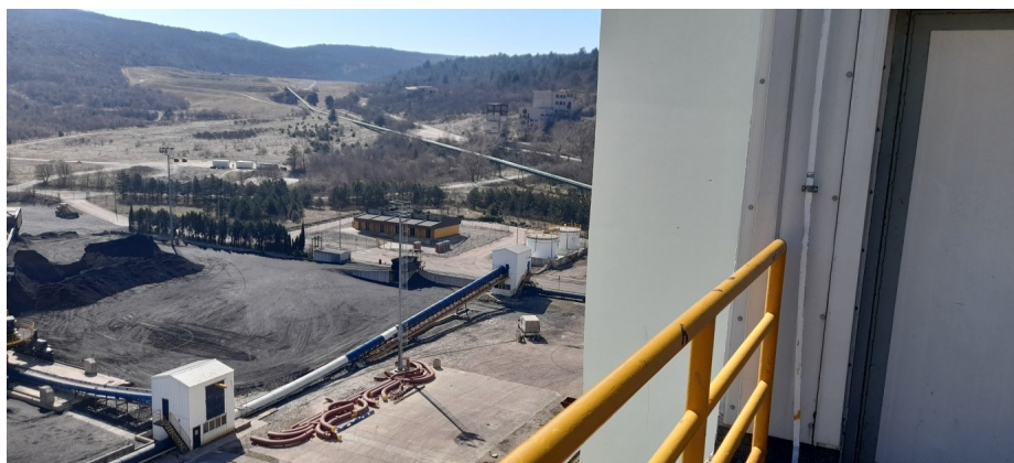
Slika 31. Odlagalište ugljena pred elektranom [autor]
