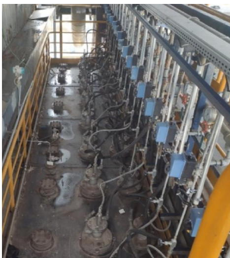
Slika 51. Tlačni sustav dušične vode [11]
