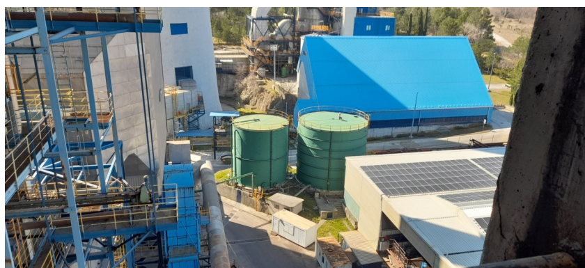
Slika 32. Spremnici sirove vode pred elektranom [autor]
