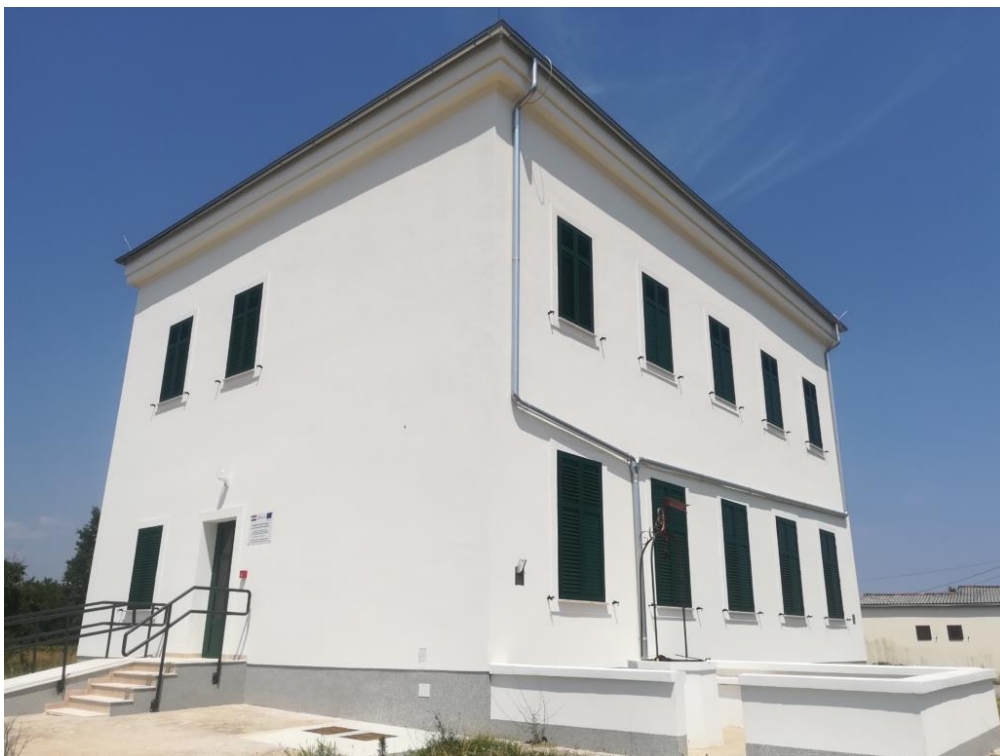
Slika 6: Zgrada Poduzetničkog inkubatora Barban (nakon provedbe projekta)
