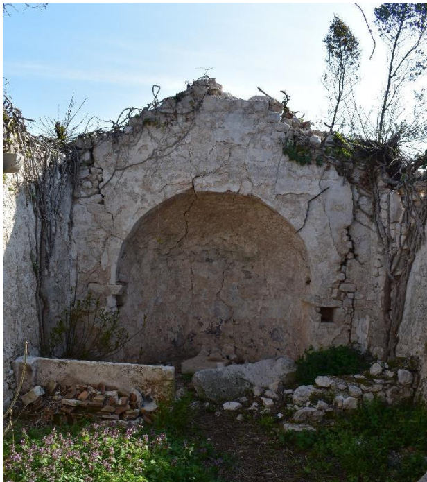
Slika 30. Unutrašnjost kapele i dio oltara
