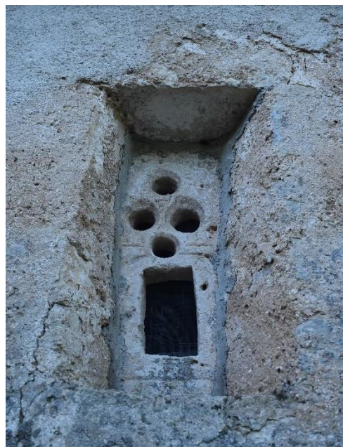
Slika 65. Prozor na sjevernom zidu
