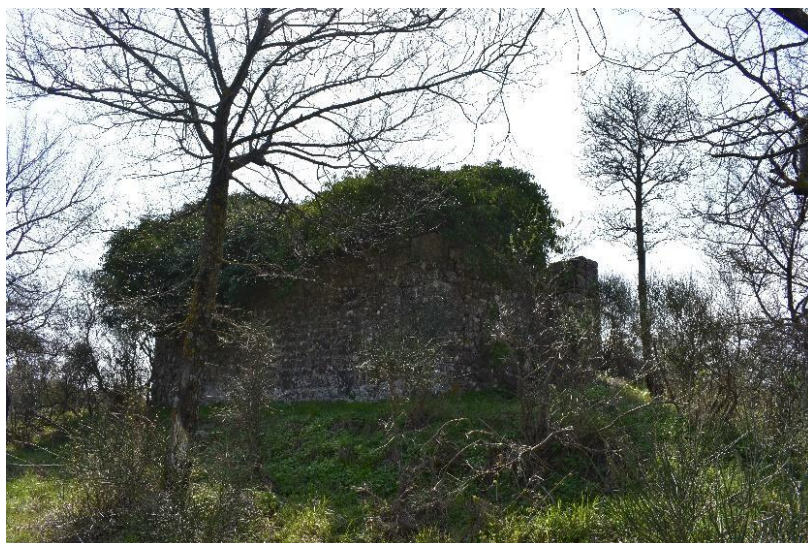
Slika 67. Vanjski izgled kapele
