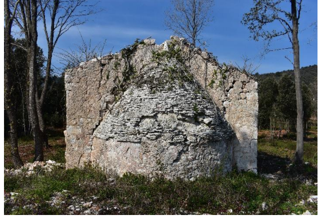
Slika 70. Vanjski izgled apside
