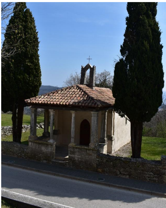
Slika 51. Vanjski izgled kapele
