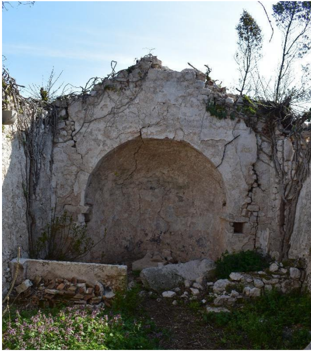
Slika 30. Unutrašnjost kapele i dio oltara
