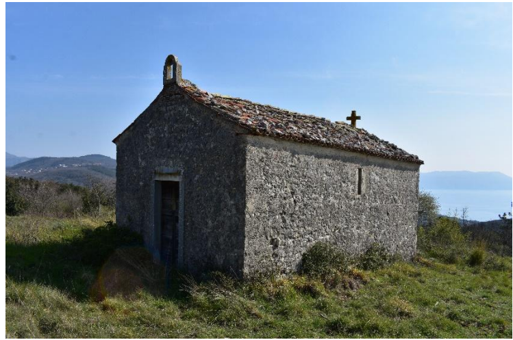
Slika 61. Vanjski izgled kapele
