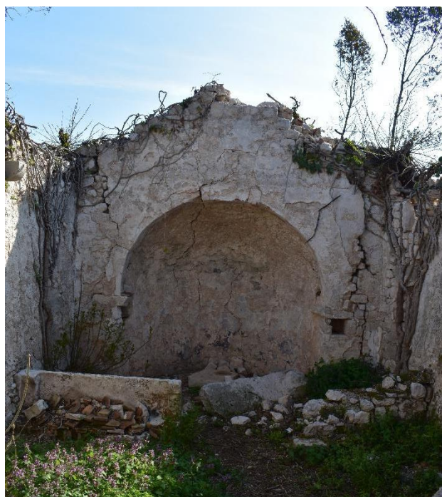
Slika 30. Unutrašnjost kapele i dio oltara
