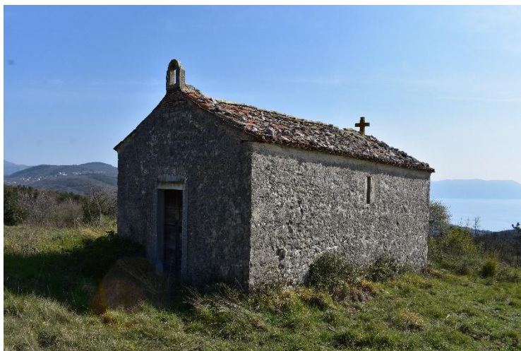
Slika 61. Vanjski izgled kapele
