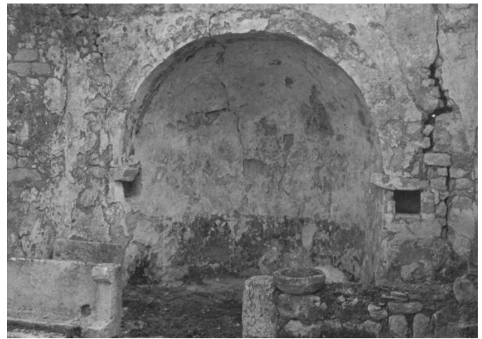
Slika 31. Unutrašnjost kapele i dio oltara
