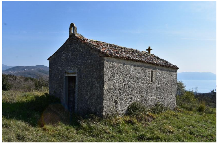
Slika 61. Vanjski izgled kapele
