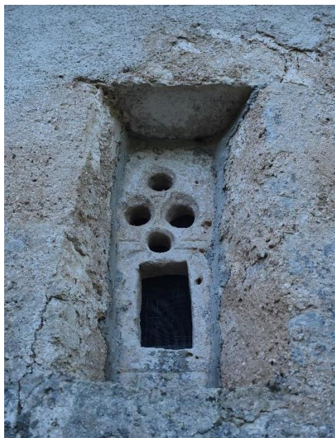
Slika 65. Prozor na sjevernom zidu
