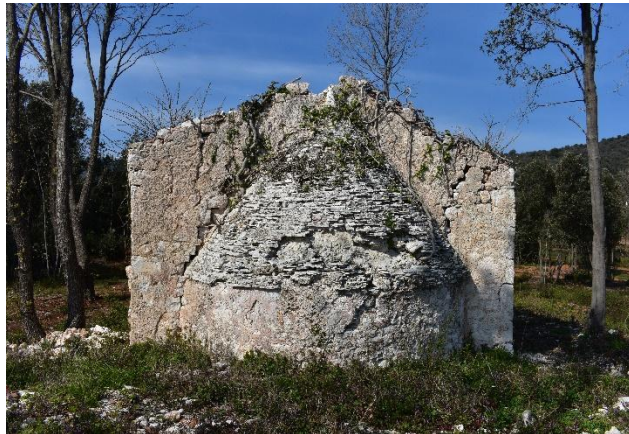
Slika 70. Vanjski izgled apside
