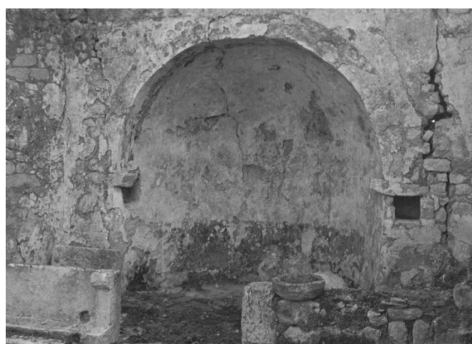
Slika 31. Unutrašnjost kapele i dio oltara
