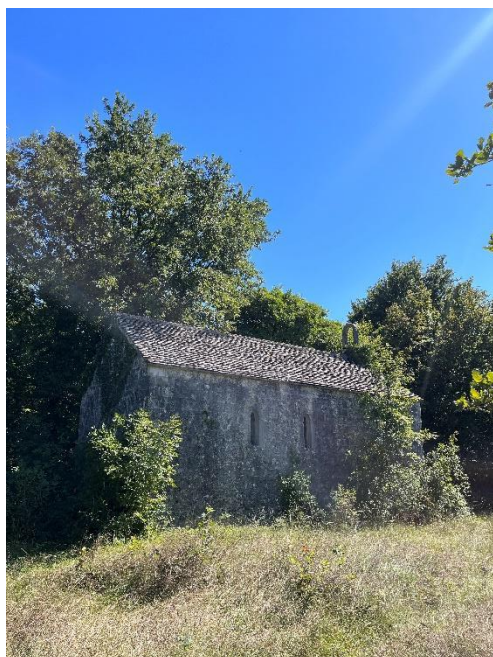
Slika 55. Vanjski izgled kapele
