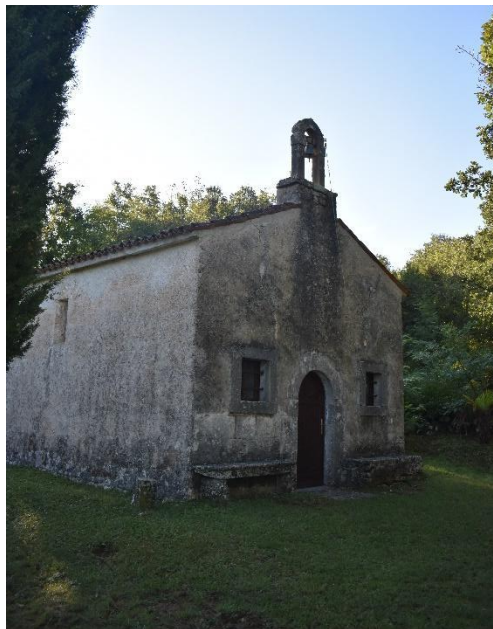
Slika 64. Vanjski izgled kapele
