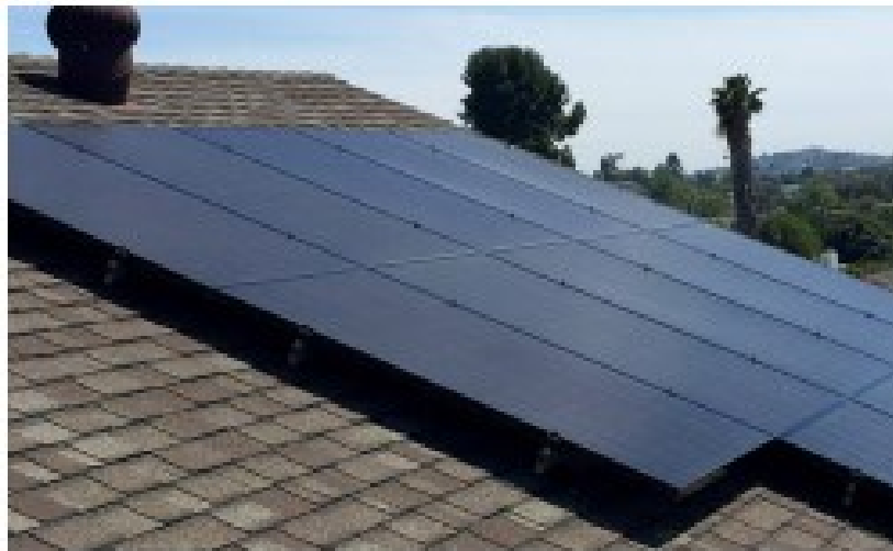
Slika 19. Fotonaponski sustav na tračnicama za kosi krov
