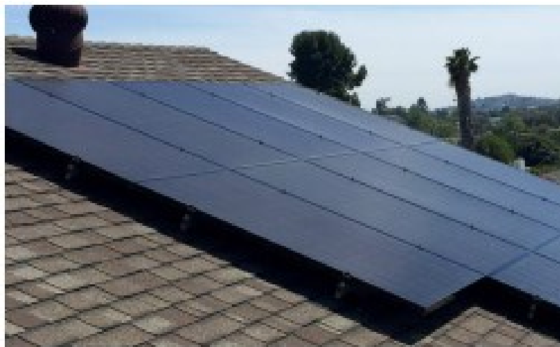
Slika 19. Fotonaponski sustav na tračnicama za kosi krov
