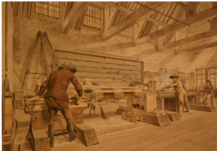
Slika 2. Horizontalna bušilica u Woolwich-u
