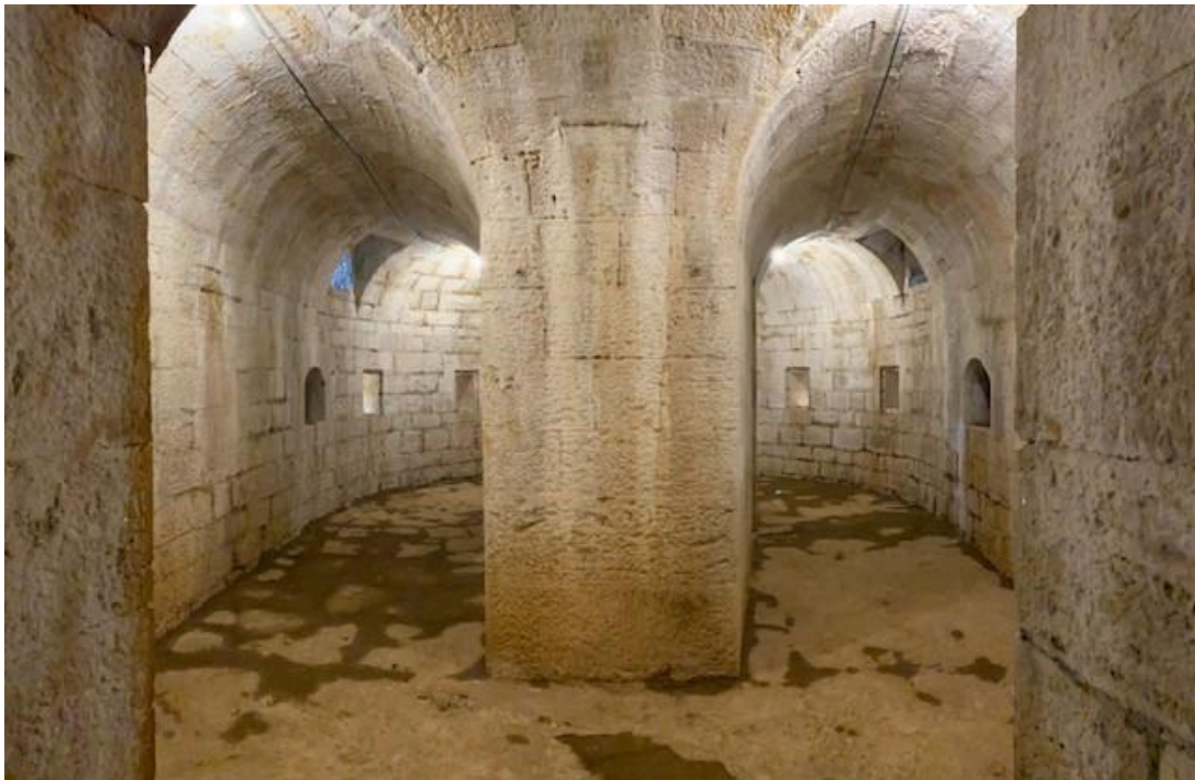
Slika 6. Unutrašnjost utvrde Punta Christo (Izvor: vlastita arhiva)
