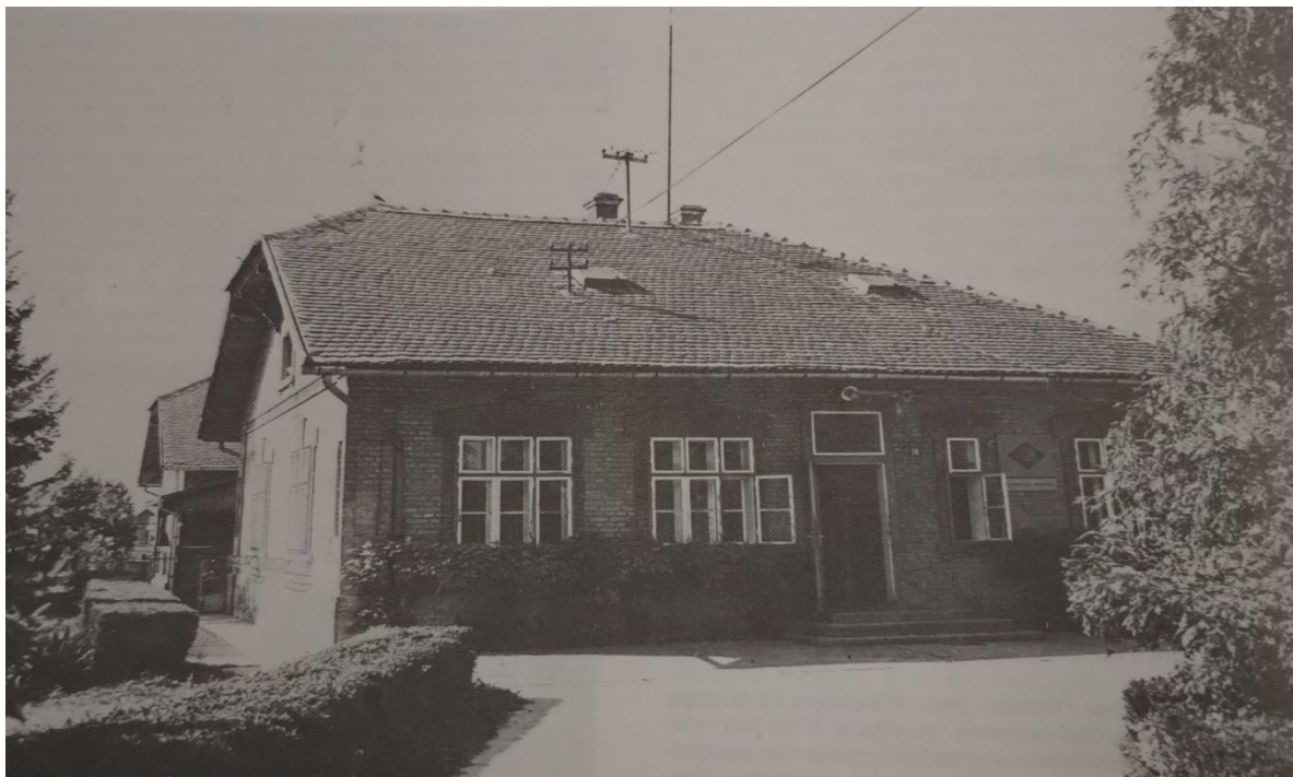
Slika 14. Pustara Brestovac, upravna zgrada
