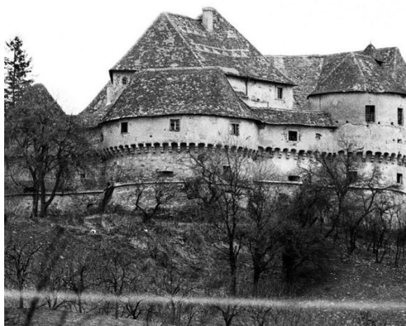
Slika 10. Veliki Tabor prije obnove
