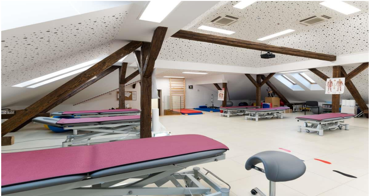
Slika 7. Rekonstrukcija dijela potkrovlja
