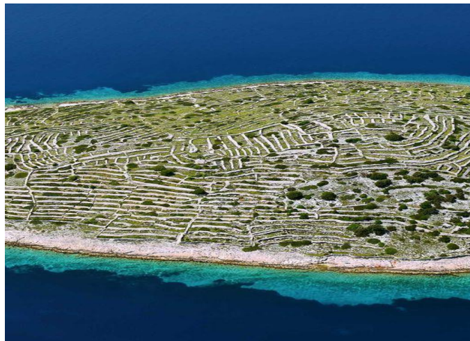
Slika 17. Umijeće suhozidne gradnje
