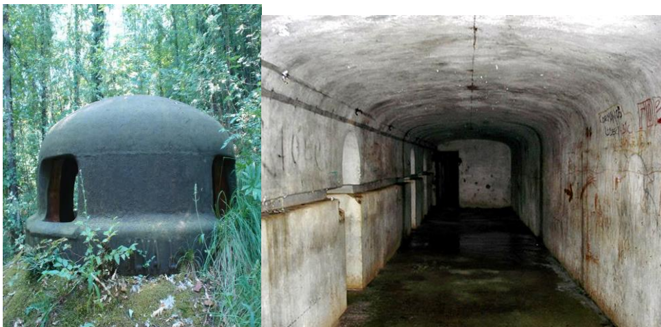
Slika 12. Bunker na Zvonećoj
