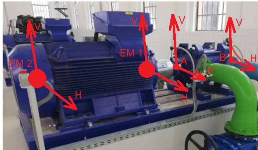
Slika 5.5 Karakteristični položaji i smjerovi mjerena vibracija CA crpne stanice Sv. Stjepan
