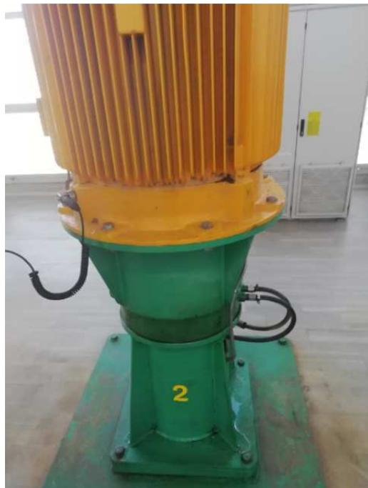
*Slika 5.11 Mjerenje vibracija u smjeru H na položaju EM1 CA 2 crpne stanice
