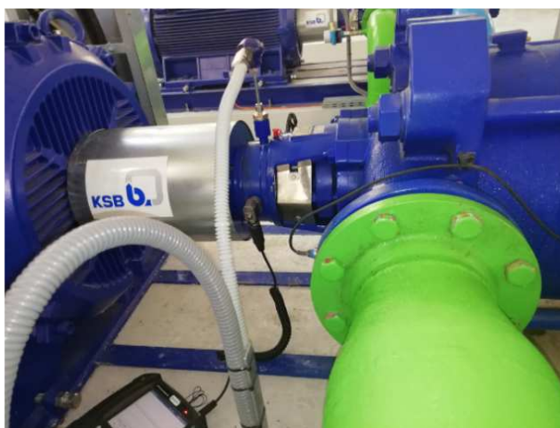
Slika 5.8 Mjerenje vibracija u smjeru H na položaju A CA 4 crpne stanice Sv. Stjepan
