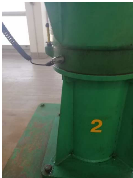
Slika 5.14 Mjerenje vibracija u smjeru H na položaju A CA 2 crpne stanice Gradole
