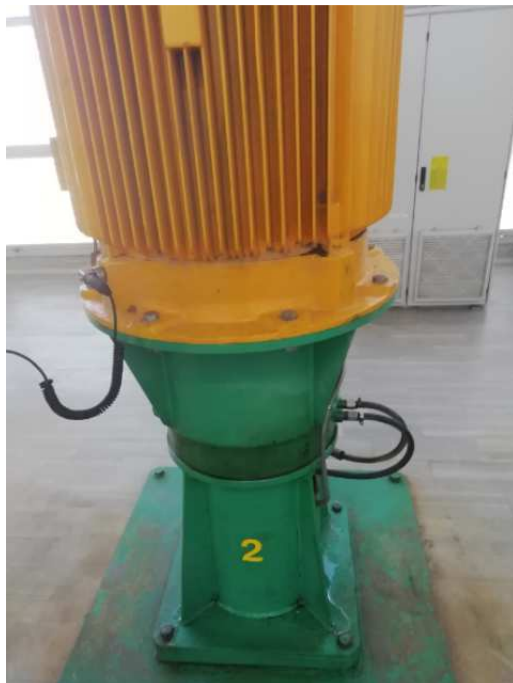
Slika 5.11 Mjerenje vibracija u smjeru H na položaju EM1 CA 2 crpne stanice Gradole
