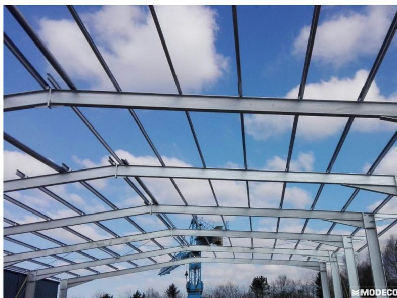
*Slika 1. Primjer čelične konstrukcije krova hale otvorenog tipa*
