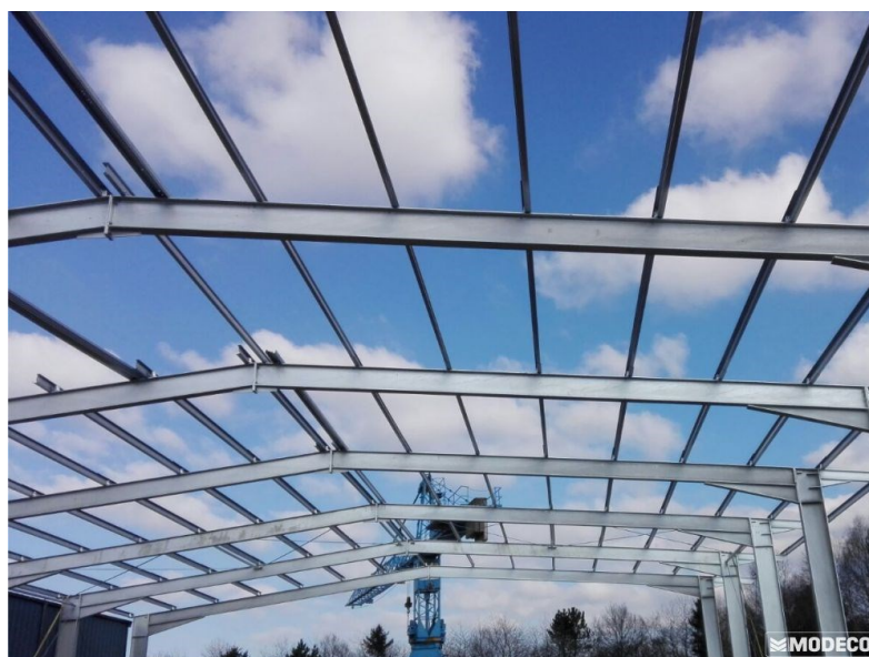
Slika 1. Primjer čelične konstrukcije krova hale otvorenog tipa
