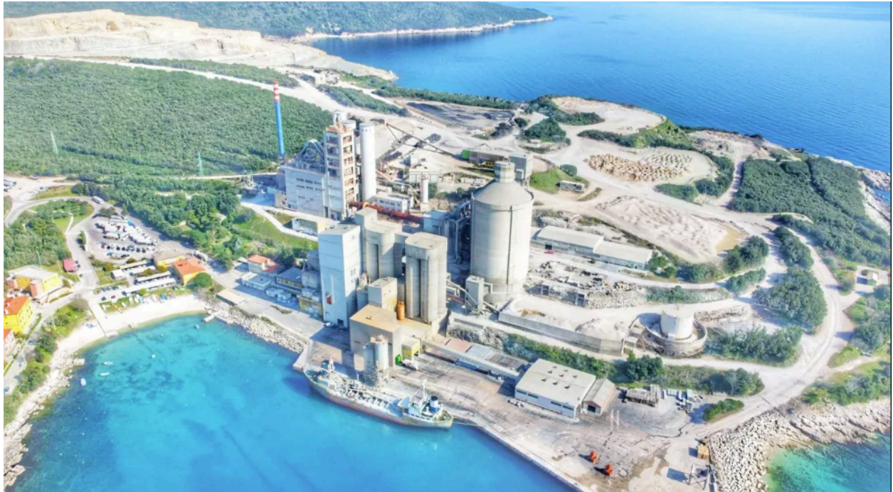
Slika 4.1. Tvornica Holcim u Koromačnom [9]
