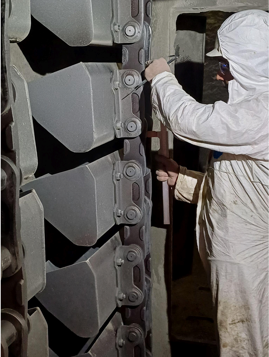
Slika 4.6.2.3. Mjerenje lanca elevatora
