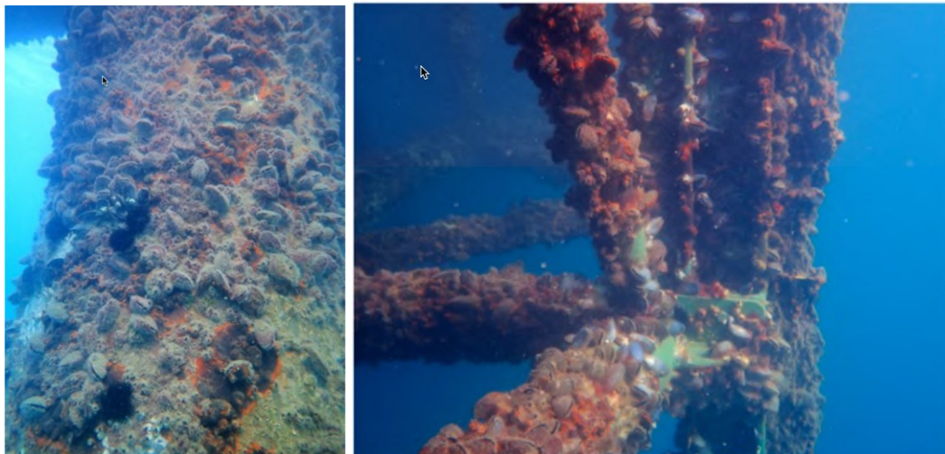
Slika 9. Obraštajna zajednica na nogaru platforme (3 m) i dagnje, crni ježinci, rakovi vitičari i kolonije mahovnjaka u obraštaju nogara na 10 m dubine.
