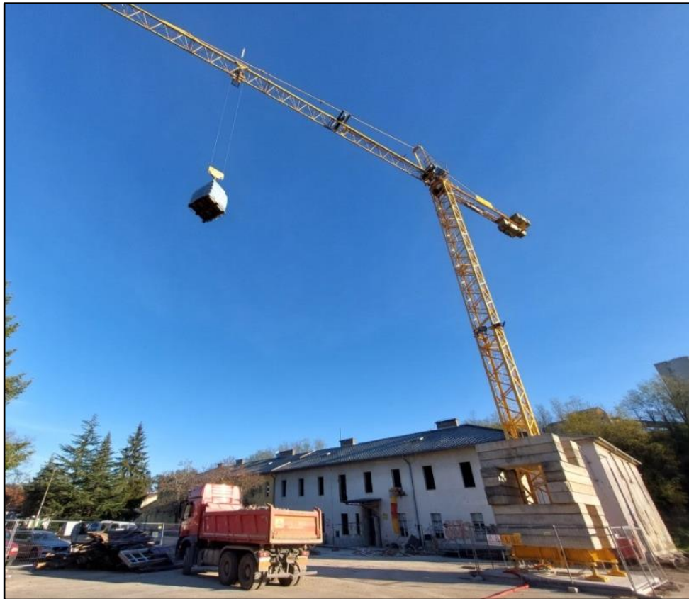
Slika 4: Dizalica Potain MC 68B - ispitivanje s opterećenjem
