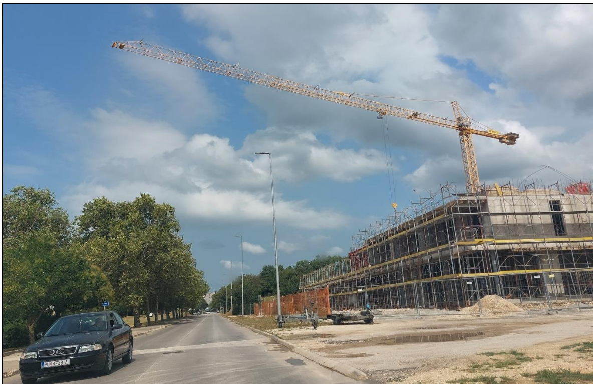
Slika 18: Ograđeno gradilište - grana dizalice prelazi iznad ceste
